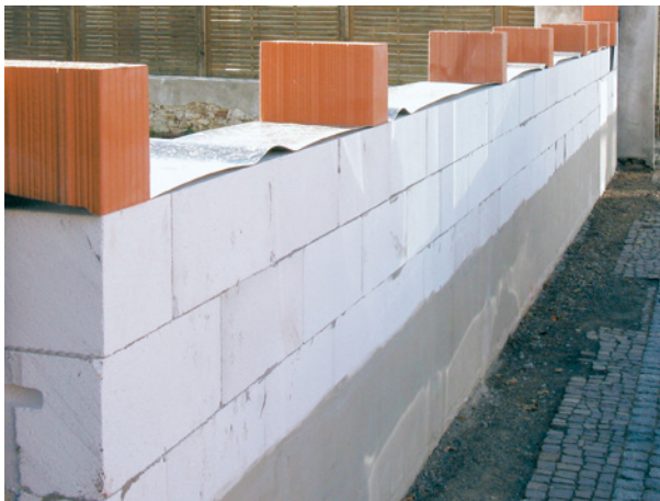
Bild 2.2 Mauerwerksabdeckung zum Schutz vor Niederschlägen im Bauzustand
