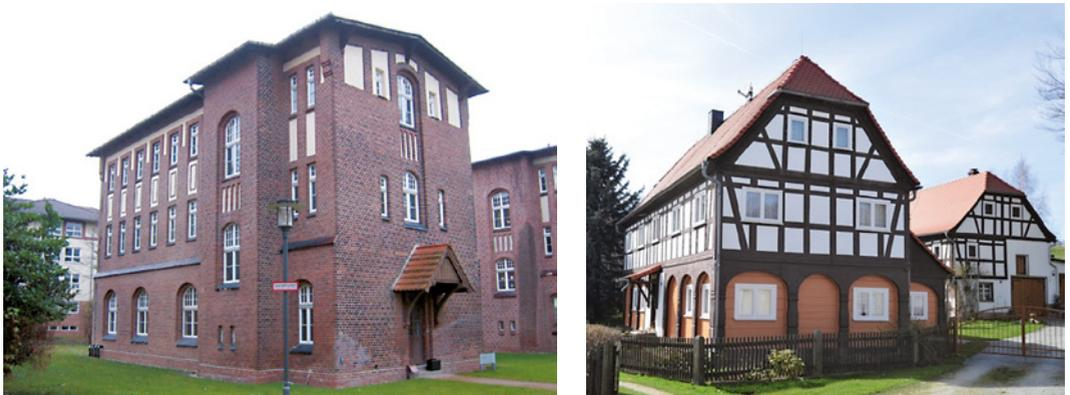
**Bild 1:** Gebäudebeispiele, für die eine thermische Ertüchtigung der Außenwände nur von innen erfolgen kann
