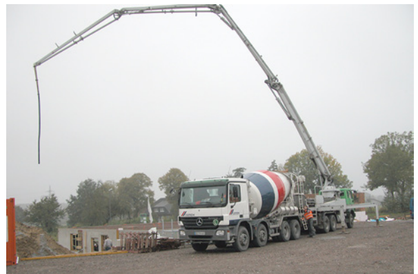
Bild 2.9: Einsatz einer Betonpumpe beim Betonieren der Elementwände
