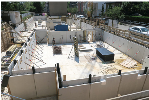
Bild 3.1: Planung einer Weißen Wanne in Elementwandbauweise
