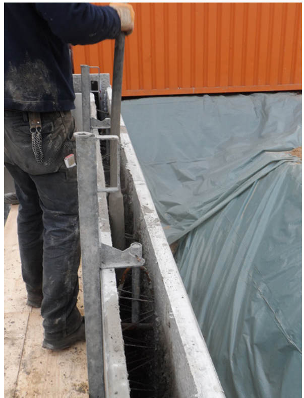
Bild 2.13: Verdichten des Betons mit einem Innenrüttler
