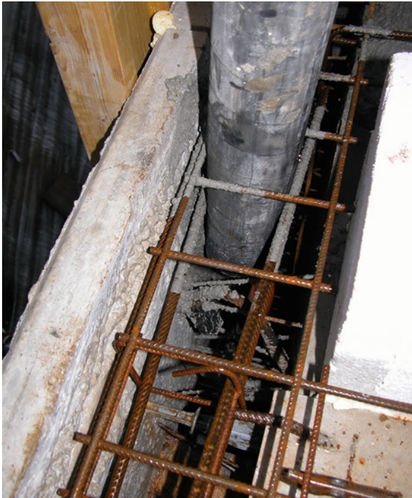
Bild 2.10: Einbringen des Ortbetons in die Elementwand mit dem Betonierschlauch
