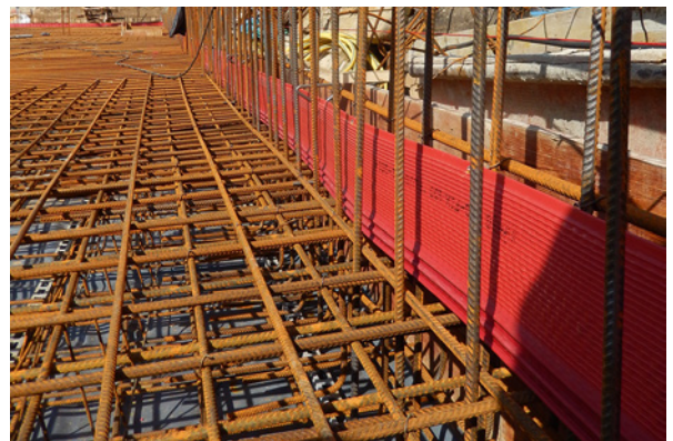
Bild 2.15: Fugenabdichtungssystem mit Arbeitsfugenband Duo-Fix 150
