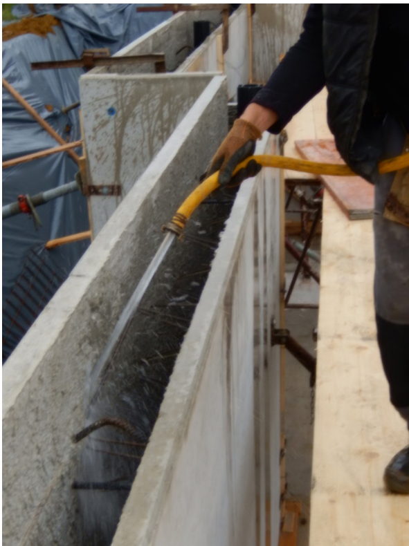
Bild 2.12: Vornässen der Arbeitsfugen und der Ortbeton-Fertigteilanschlüsse vor dem Betonieren
