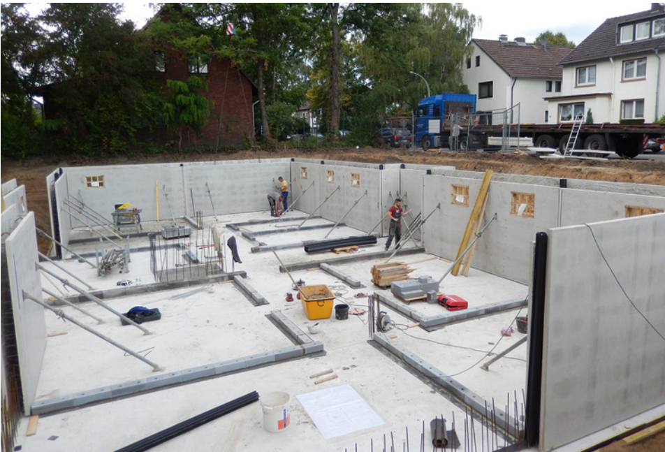
Bild 2.1: Kellergeschoss in Elementwandbauweise
