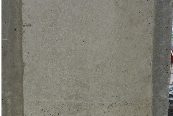
Bild 1.3: Elementwand mit monolithisch wirkendem Wandquerschnitt
