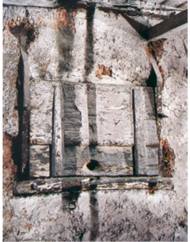
Abb. 1.16: Esslingen, Hafenmarkt 10: Brettfläche mit Gratleisten und Wendezapfen als Verschluss an einer Kammeröffnung von 1331: Für das frühe 14. Jahrhundert war dies bereits ein komfortabler Fensterverschluss, der ohne die teuren eisernen Beschläge gefertigt werden konnte. (Quelle: Ewald/Köhle-Hezinger/Könekamp, 1991, S. 37)
