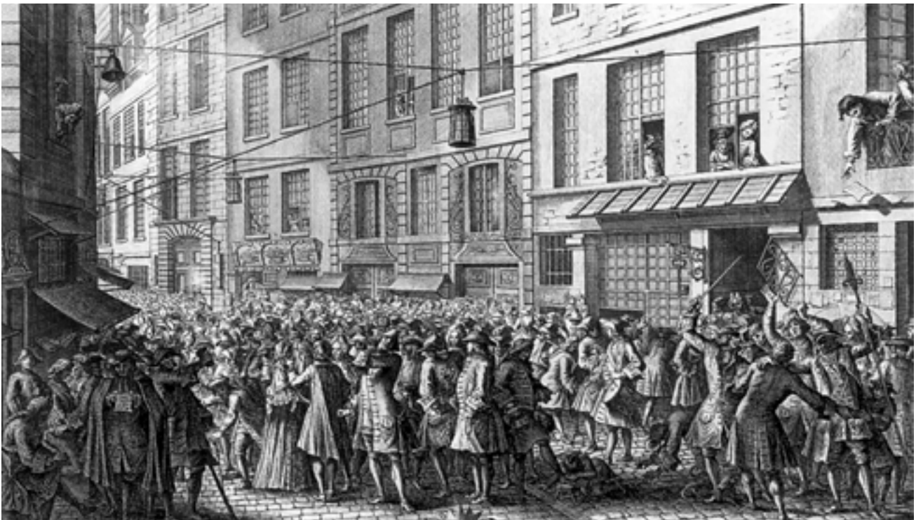
Abb. 1.55: Paris, Rue Quinquepoix, 1720: Im gesamten Straßenzug sind Vertikalschiebefenster zu erkennen. (Quelle: Fleury, 1997, S. 13)
