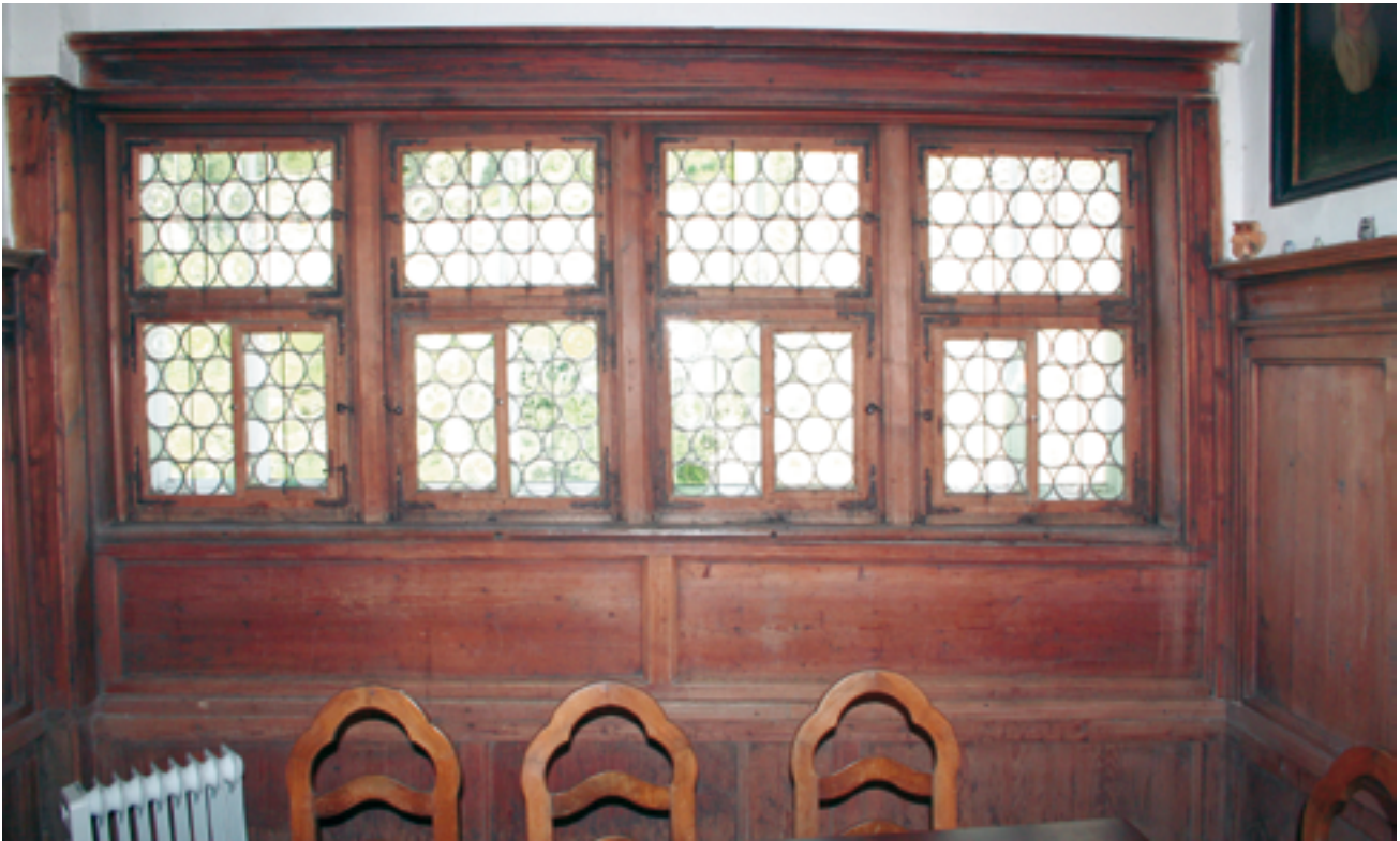
Abb. 1.23: Herrenberg, Schlossberg 1, ehemaliges Chorherrenstift, heute evangelisches Dekanatamt: Der für diese Zeit – 1577 – ausgereifte Fensterverschluss erstreckt sich über die gesamte Außenwand. Er verfügt über Drehflügel sowie einen zusätzlichen Lüftungsflügel und außen angebrachte Ziehläden.
