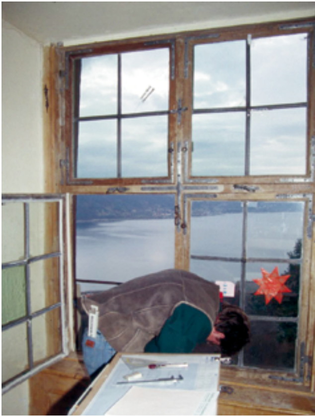
Abb. 1.26: Bodman, Kloster Frauenberg, erbaut 1611: Verglasung und Binnengliederung des bauzeitlichen Fensters wurden barockisiert. Im unteren Flügel waren ursprünglich zusätzliche Lüftungsschieber angeordnet.
