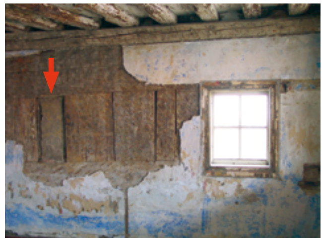
Abb. 1.14: Leutkirch, „Gotisches Haus“, erbaut 1377, Bohlenstube im zweiten Obergeschoss: Links ist eine jetzt zugemauerte originale schmale bauzeitliche Fensteröffnung mit Fensterfalz zu erkennen (siehe Markierung); die rechte Fensteröffnung ist sekundär.
