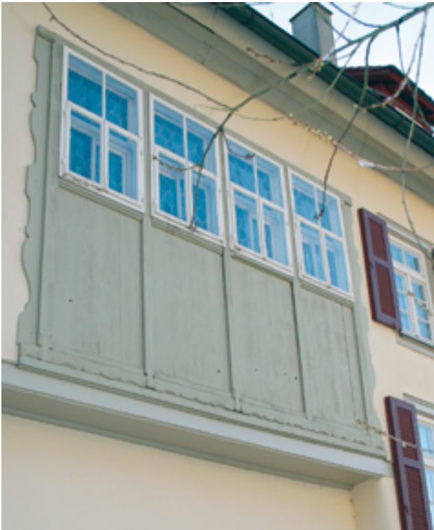
Abb. 1.36: Herrenberg, Schlossberg 1, evangelisches Dekanatamt, Fensterband von 1577: Fenster und Ziehläden sind vollständig erhalten. Um 1920 wurden zum Schutz der Renaissancefenster und als wärmetechnische Verbesserung außen in die Ebene der Ziehläden zusätzlich Vorfenster eingestellt.
