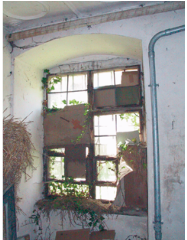
Abb. 1.28: Inzigkofen, Kloster, erbaut 1659: einziges Fenster des bauzeitlichen Bestandes, Verglasung sekundär
