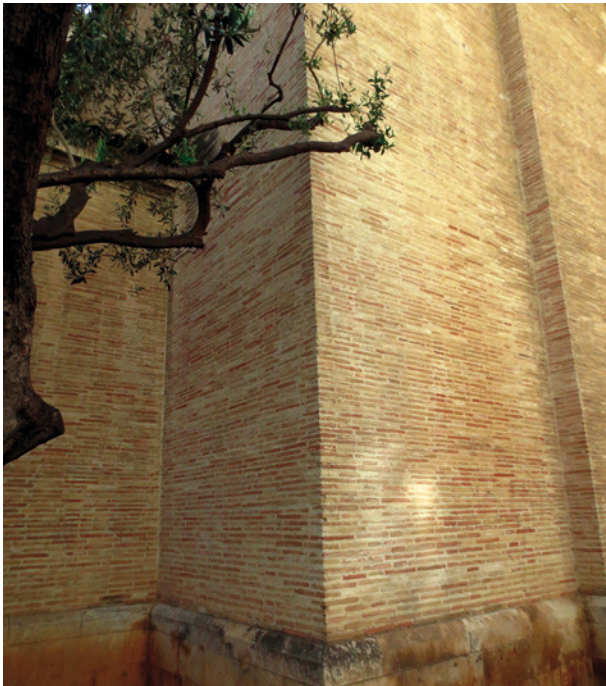
Bild 21 ■ Verwendung von kleinstformatigen gotischen Ziegeln an der Kathedrale von Valencia, Spanien
