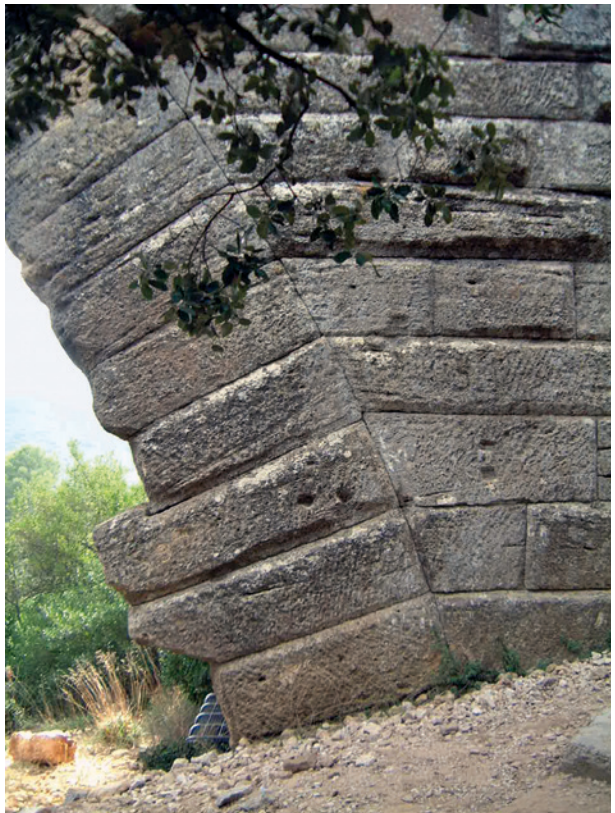
Bild 6 ■ Detail des Trockenmauerwerks (Pont du Gard, Südfrankreich)
