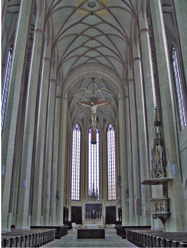
Bild 10 ■ Mittelschiff der Kirche St. Martin und Kastulus in Landshut; Pfeiler mit 22 m Höhe und nur 1 m Breite
