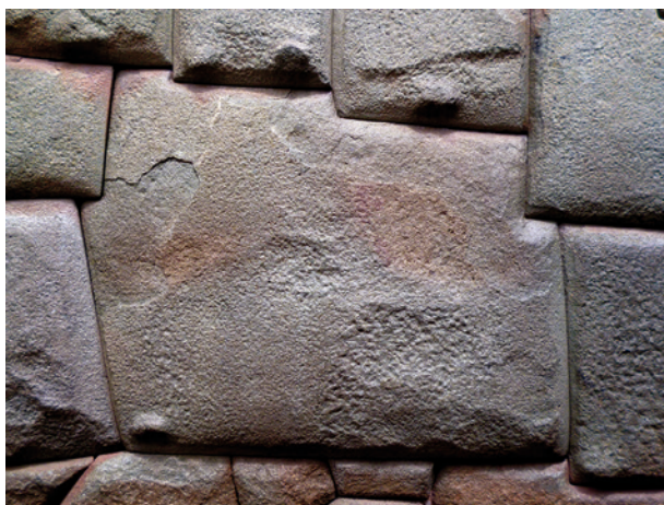
Bild 9 ■ Perfekter zwölf-eckiger Stein (Zyklo-pen-mauerwerk) in der Calle Harunrumiyoc in Cusco als Zeugnis der großen Baukunst der Inkas
