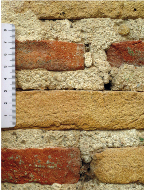
Bild 22 ■ Detail aus Bild 21: nur 20 bis 30 mm hohe Ziegel
