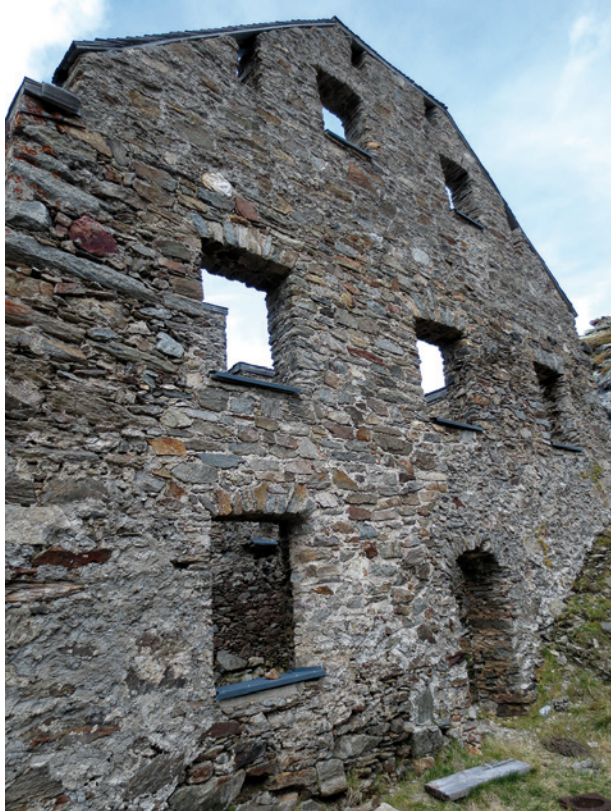
Bild 12 ■ Seit mehr als 150 Jahren ohne jegliche Aussteifung frei stehender Natursteingiebel im Hochgebirge (Knappenhäuser im österreichischen Nationalpark Hohe Tauern in 2341 m Höhe)
