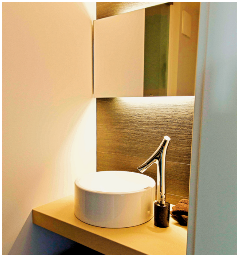
Abb. 1.14: Die Waschtisch-Schale liegt auf einer als Konsole ausgebildeten Steinplatte, die nahtlos zwischen den Wänden spannt.
