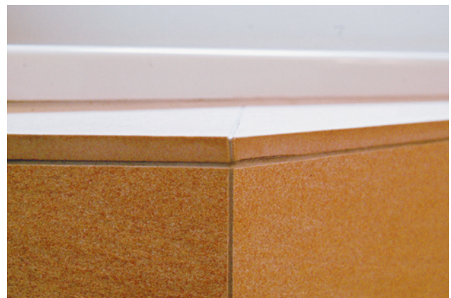
Abb. 1.25: Die Verfliesung erfolgt mit stumpfer Kante, wodurch die Ecken in den Hintergrund treten.
