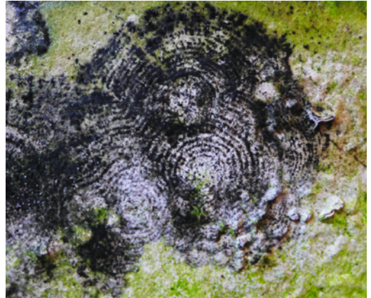
Abb. 1.26: Vergrößerte Ansicht der Algenbildung und des Schimmelpilzbefalls aus Abb. 1.25
