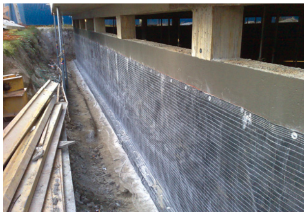
Abb. 1.9 ■ Vertikalabdichtung mit Bentonitmatten (Quelle: BPA GmbH)
