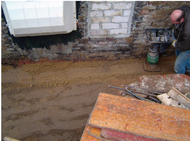
Abb. 1.11 ■ Einbringen einer Vertikalabdichtung (Quelle: Dernbach)
