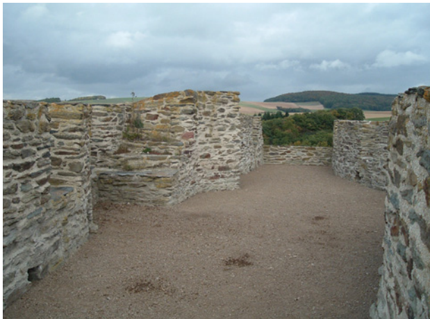
Abb. 1.12 ■ Obere Horizontalabdichtung einer Burgruine (Quelle: Dernbach)
