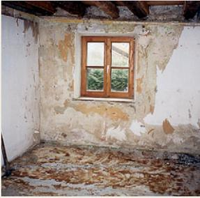
Die Wände im Erdgeschoss waren mit Holz vertäfelt. Darunter sammelte sich Feuchtigkeit.
