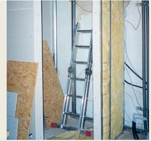
Nur im EG blieben die Innenwände, im restlichen Teil wurden sie im Trockenbau neu erstellt.
