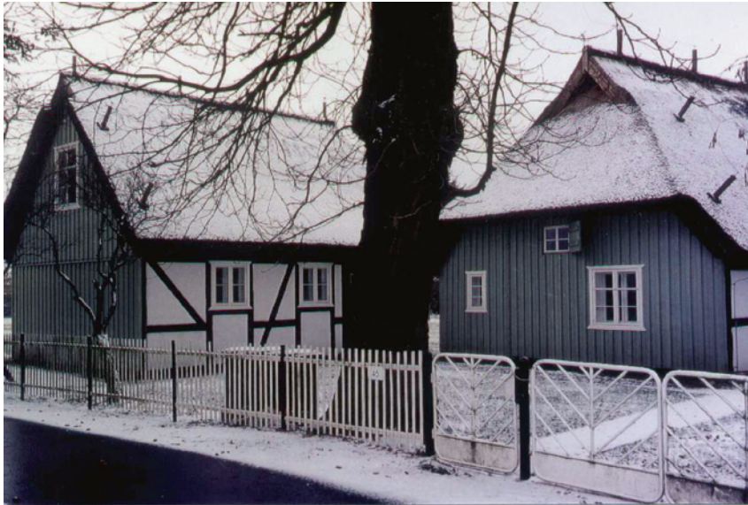
Bild 2-11 Teilverschalung an der Wetterseite
