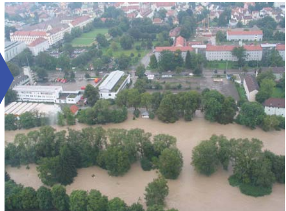
Abb. 3 Hochwasser in Kempten 2005, Feuerwehr (s. Abschnitt 5.2)
