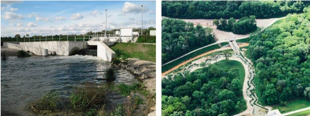
Abb. 3-2: Links: Ausleitungsbauwerk mit Tosbecken und Fischpass. Rechts: Ottheinrichbach mit kurzer Anbindung zum stark getrübbten Längenmühlbach und Trogbrücke. Im Hintergrund der Beckenpass nach der Trogbrücke (noch ohne Wasser) und die obere Flutmulde (Bereich hinter der freistehenden Baumgruppe), die bei Ökologischen Flutungen das Wasser in den Auenwald führen soll (Fotos: Peter Fischer).
