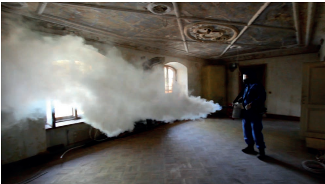
Bild 7: Fogging zur Schimmelbekämpfung
