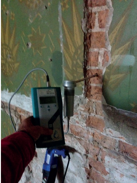
Bild 11: Tiefenfeuchtemessung mit Mikrowellen
