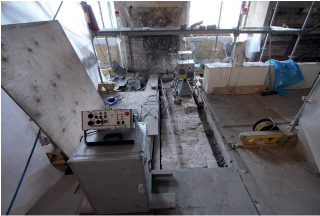
Bild 12: Mikrowellentrocknung des Mauerwerks
