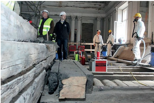
Bild 9: Absaugen der Schimmelsporen in der weißen Halle
