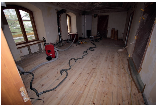
Bild 14: Trocknung der Holzbalkenlagen
