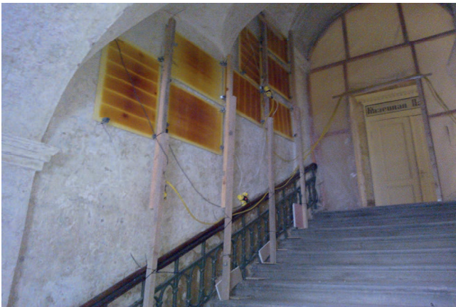
Bild 13: Infrarottrocknung im Treppenhaus
