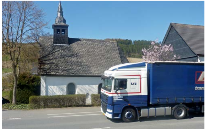
Abb. 1.1: Lage der Kapelle an einer stark befahrenen Bundesstraße
