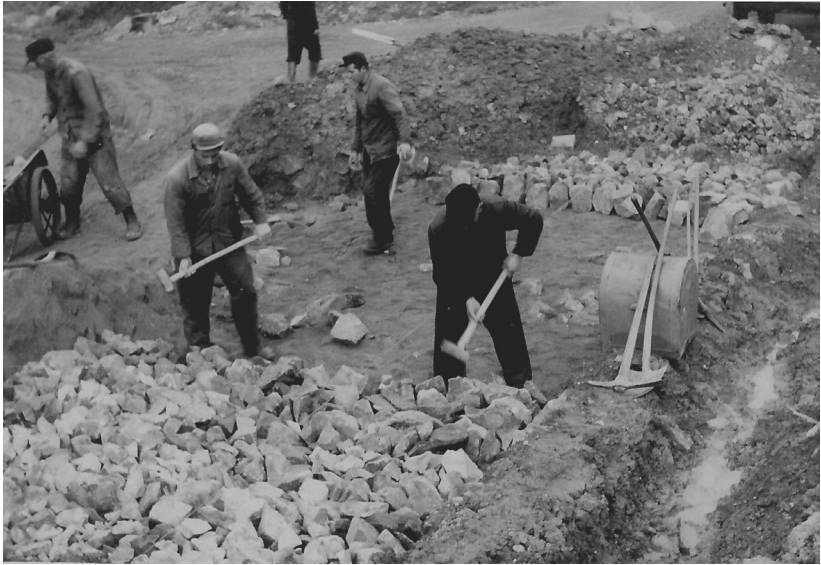
Abbildung 1 Herstellen einer Packlage 1957
