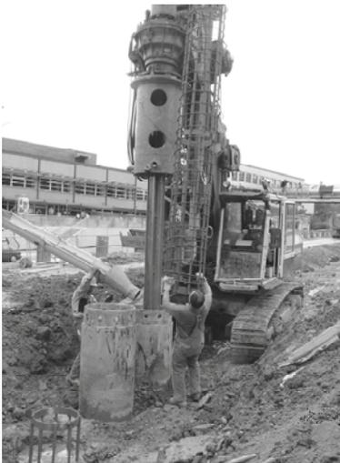
**Bild 1.3:** Herstellung eines Bohrpfahls
