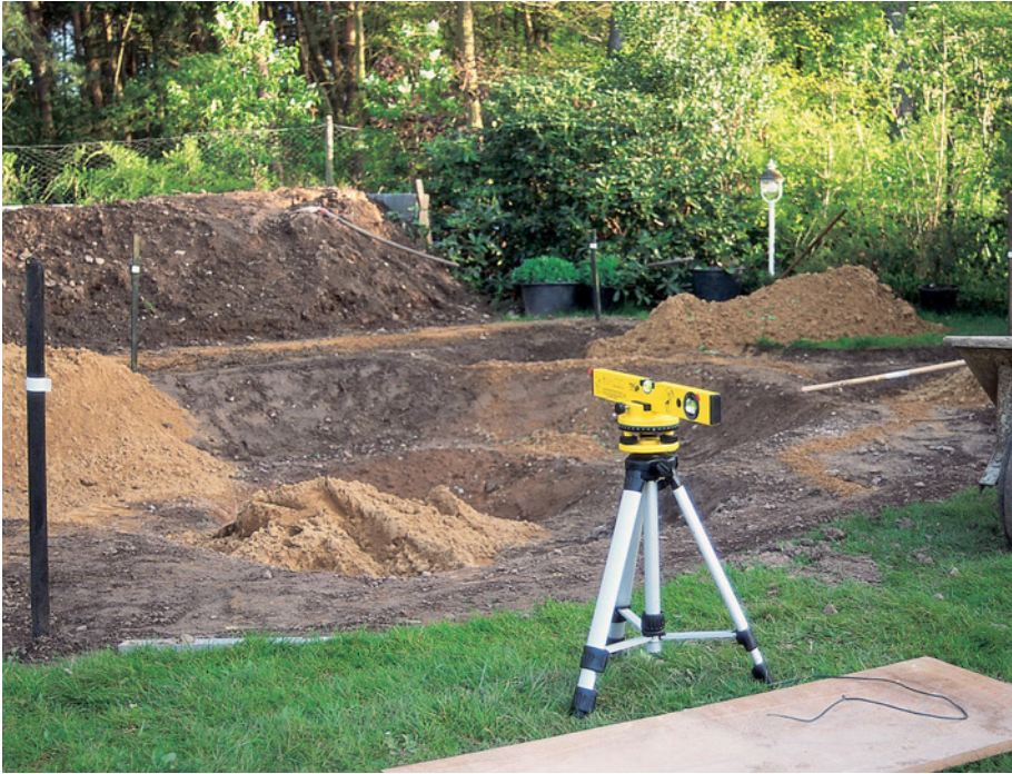
Mit einer Laserwasserwaage lassen sich Teichränder genau einlesen.
