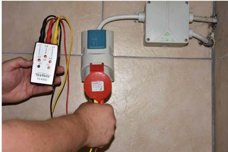
Ist die Drehstromsteckdose korrekt angeschlossen, muss ihr Drehfeld in den Uhrzeigersinn weisen.
