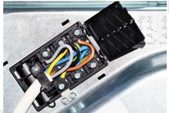
Anschlussfeld eines Einbauherds.
