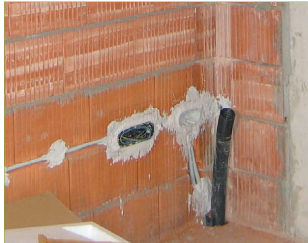
Abb. 5.1 – Für die Antennenverkabelung sollten Sie im Rohbau separate Elektroinstallationsschläuche verlegen (rechts im Bild).
