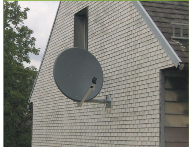
Abb. 5.7 – Eine optisch auffällige Konstruktion: An der Seitenwand des Hauses sollte man die Antenne deshalb nur installieren, wenn sonst keine Sichtverbindung zum Satelliten herzustellen ist.
