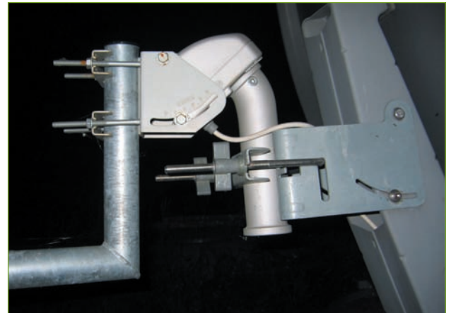
Abb. 1.16 – Bestehende Satellitenschüsseln lassen sich leicht und preiswert mit DiSEqC-Motoren zu Drehanlagen erweitern, die alle Satelliten am Himmel mit ausreichendem Signalpegel empfangen.
