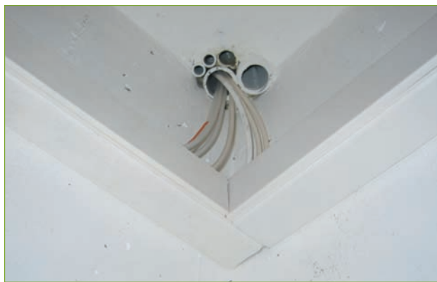
Abb. 5.2 – Ein Kabelschacht vom Dachboden zum Keller mit mehreren Elektroinstallationsrohren. Im Keller liegen die Antennenkabel auf Putz in Installationsschächten, die als weiße Balken zu erkennen sind.
