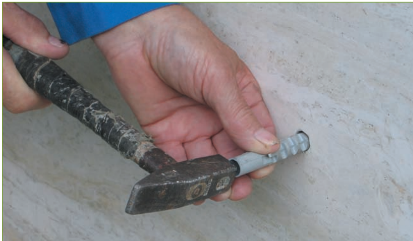
Abb. 5.13 – Dübel in der Hauswand geben Schrauben den nötigen Halt.
