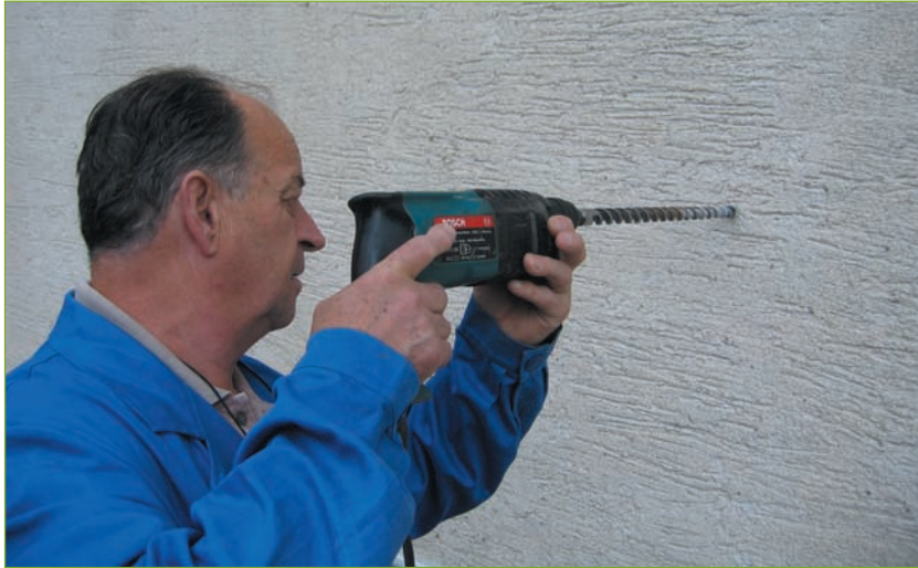
Abb. 5.12 – Um das Antennenkabel in die Wohnung zu bringen, ist ein langer Steinbohrer erforderlich.
