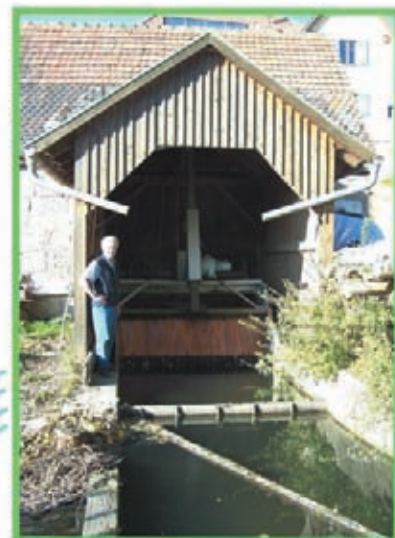
Zulauf Mühlbach mit Wehr und Rechen zum Wasserkraftwerk
