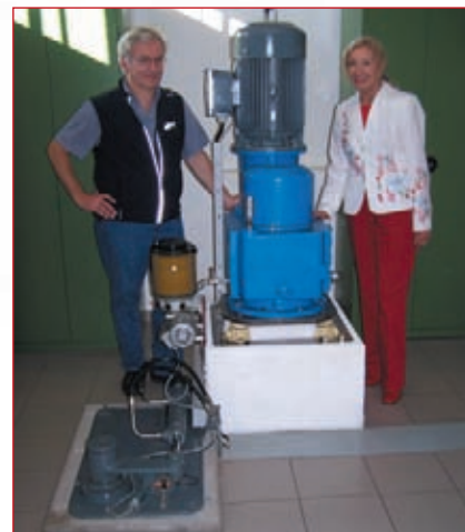
Abb. 81 – Der elektrische Generator (mit Getriebe) des Klein-Wasserkraftwerkes aus Abb. 80
