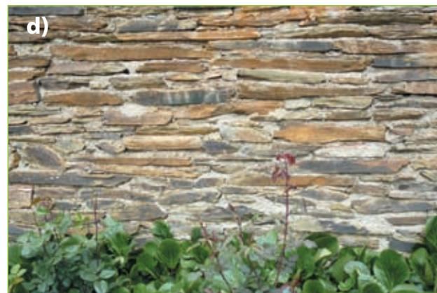
**Abb. 1.20** – Für Gartenmauern gibt es viele Gestaltungsmöglichkeiten: **a)** Natursteinmauer zur Einrahmung und Abstufung der Terrasse zum Garten, **b)** und **c)** Mauer aus befüllten Drahtschotterkörben. Als Material kann auch Recyclingmaterial verwendet werden. **d)** Schichtmauer mit unregelmäßigen Natursteinplatten.
