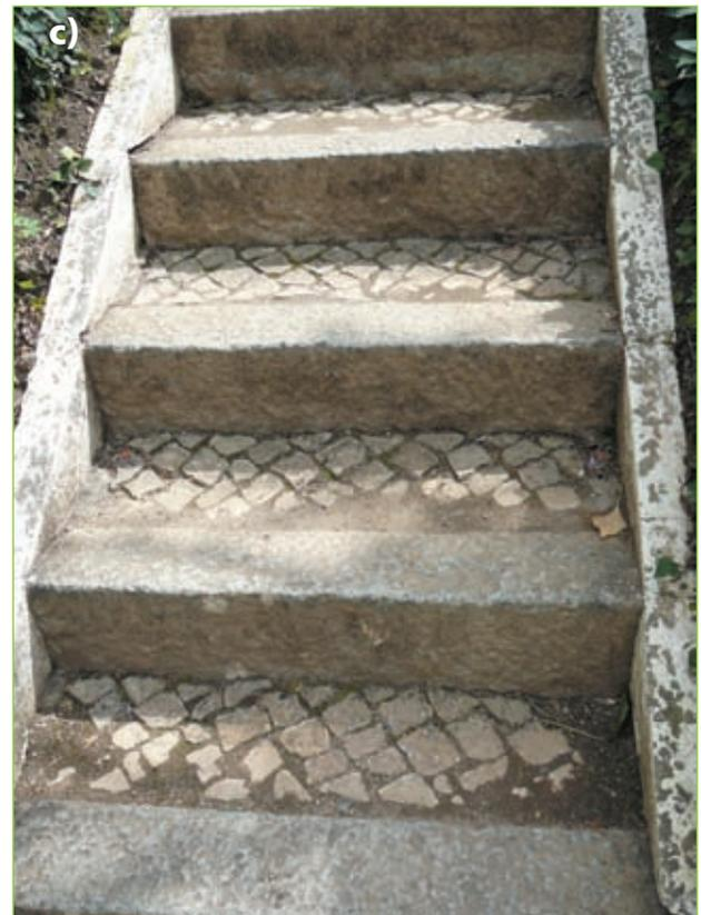
**Abb. 1.19 – a)** Treppenanlage eines Hauszugangs, **b)** Seitenansicht der in Beton gesetzten Blockstufen, **c)** Stellstufen mit ausgepflasterter Stufenfläche und seitlichen Stufenwangen.
