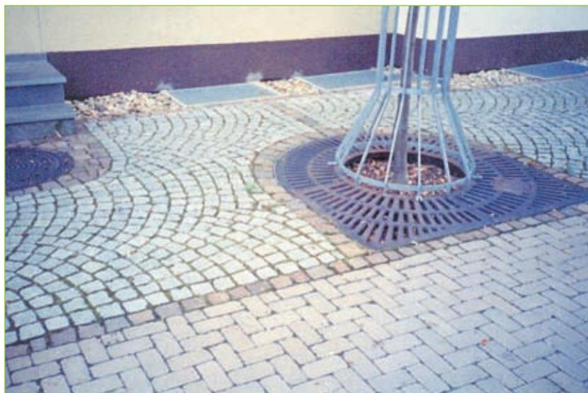
Abb. 1.21 – Bodenbeläge, kombiniert aus Natur- und Betonstein.
