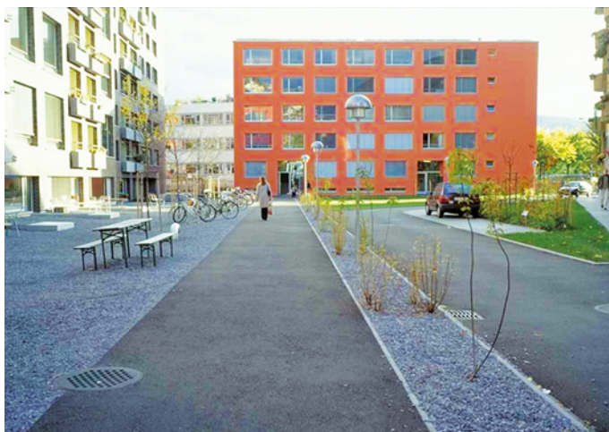
Bild 1: KraftWerk1, Wegweisende Wohnsied- lung in Zürich: Umsetzung einer sozialen Utopie des Zusammen- lebens
